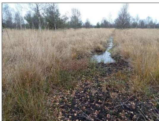
Abbildung 3: Punktueller Grabenverschluss. Der Torfpropp verhindert die Entwässerung.
