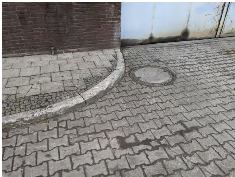
Foto 9: Standort RKS 9 (unterirdischer Tank)
