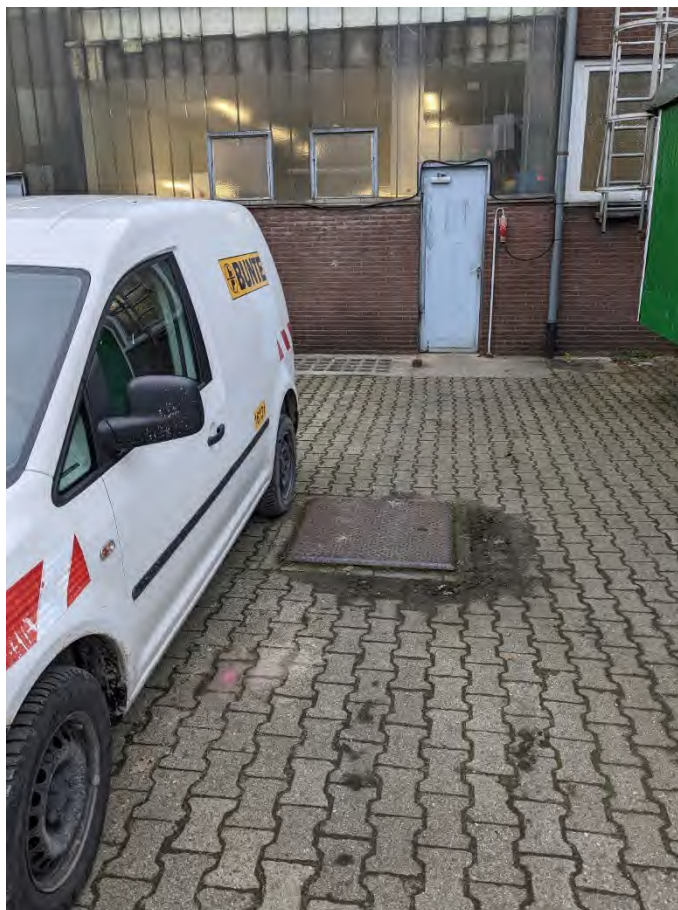
Foto 11: Standort RKS 11 (unterirdischer Tank)
